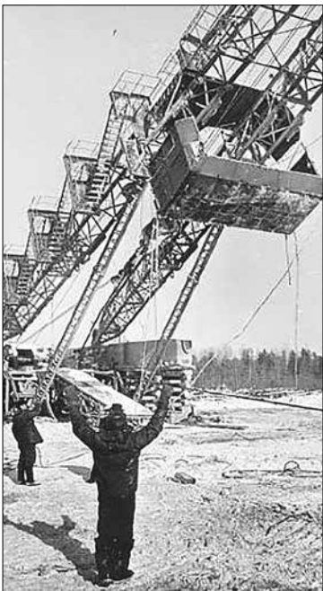
Установка буровой вышки на Мегионском месторождении
