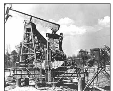
С 1974 года в «Мегионнефти» началось внедрение механизированного способа эксплуатации скважин
